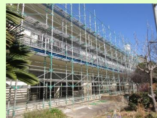
外壁工事 R5.3.1
